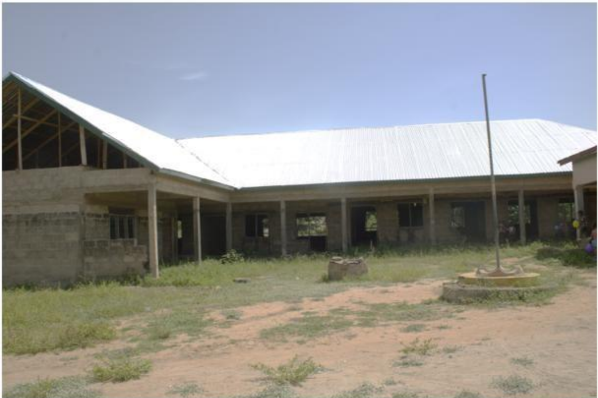
Redemption Academy – het dak zit erop!
