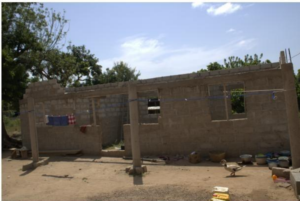
Buitenkeuken in aanbouw
